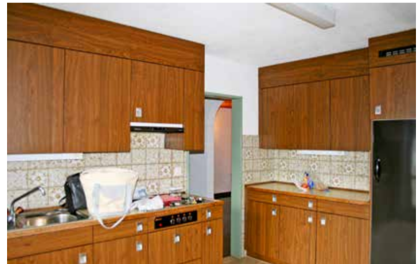
Die deutlich in die Jahre gekommene Küche vor dem Umbau.
